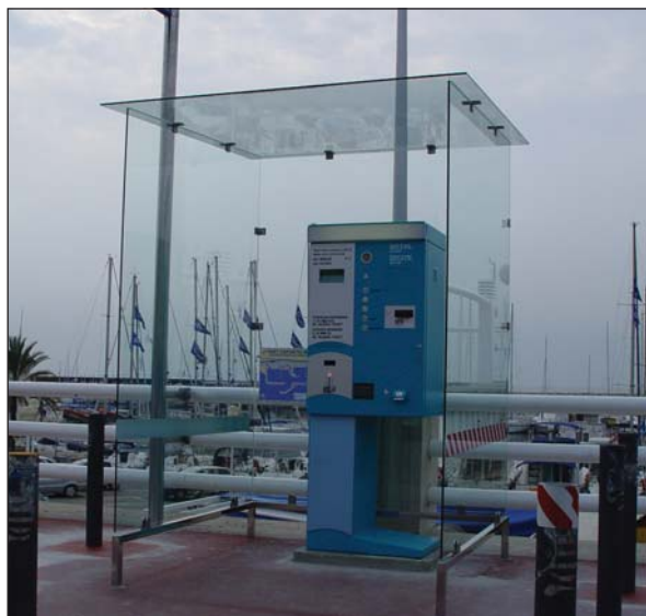
Marquesina vidrio templado.
