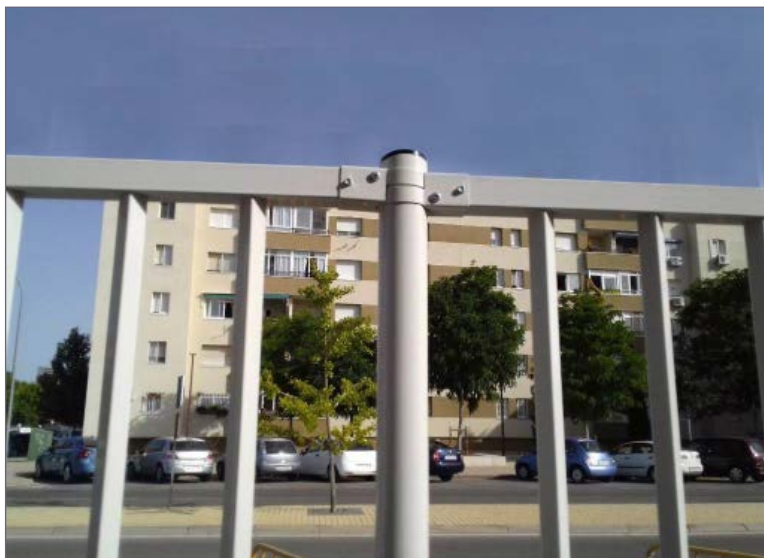
Detalle vallazo ZF enmarcada.
