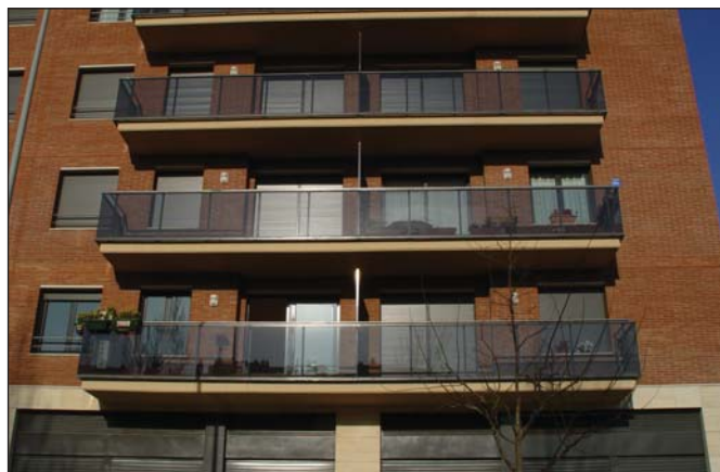
Balcones combinación de hierro, acero inoxidable y vidrio.
