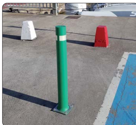
Detalle base con placa reforzada.
