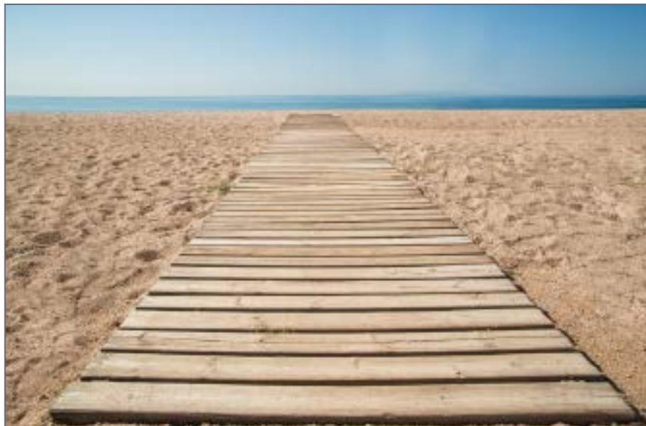
**Pasarela de madera** fabricada en pino tratado con autoclave.
