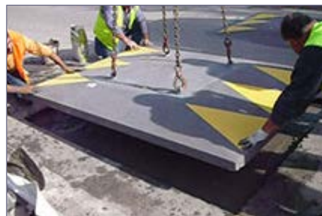
Instalar la pieza mono bloque.
