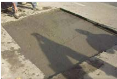
Rellenar superficie con hormigón.
