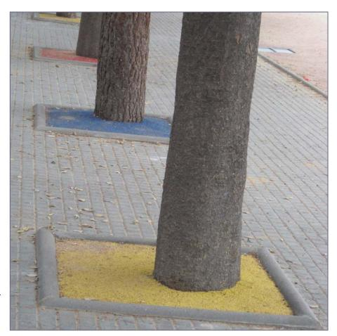
Alcorque de caucho reciclado en diferentes colores a elegir. Se coloca en diferentes capas de distinta granulometría adheridas con resina.
