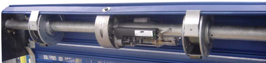
Motor instalado en eje puerta enrollable.
