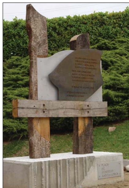
Monumento con traviesas, pie de hormigón y Chapa hierro corte con letras realizadas mediante calado con máquina de corte a laser.
