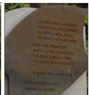
Monumento con traviesas, pie de hormigón y Chapa hierro corte con letras realizadas mediante calado con máquina de corte a laser.
