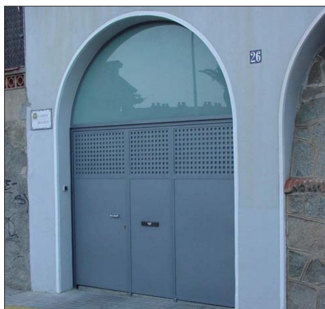
Puerta metálica con arcada de vidrio.
