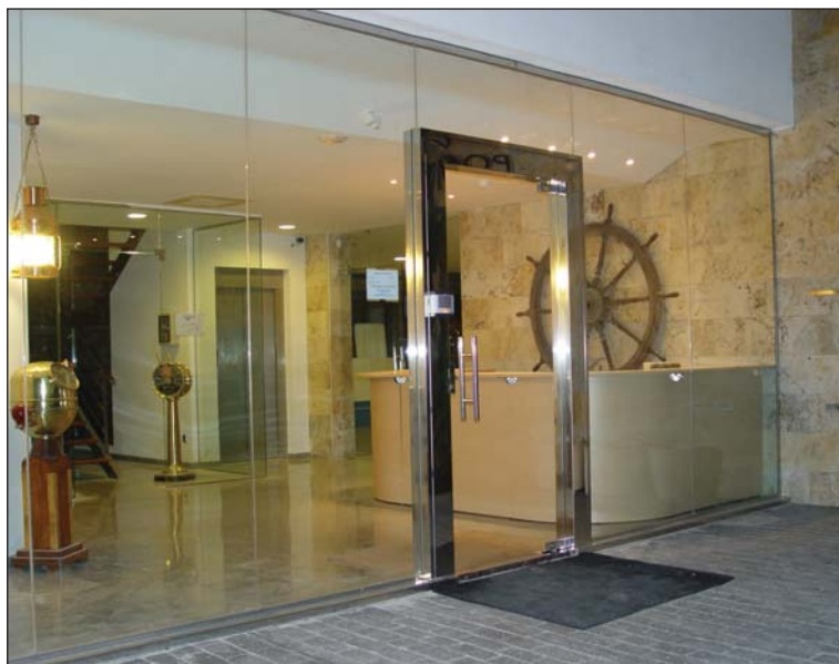
Fijo vidrio con puerta enmarcada en acero inoxidable.
