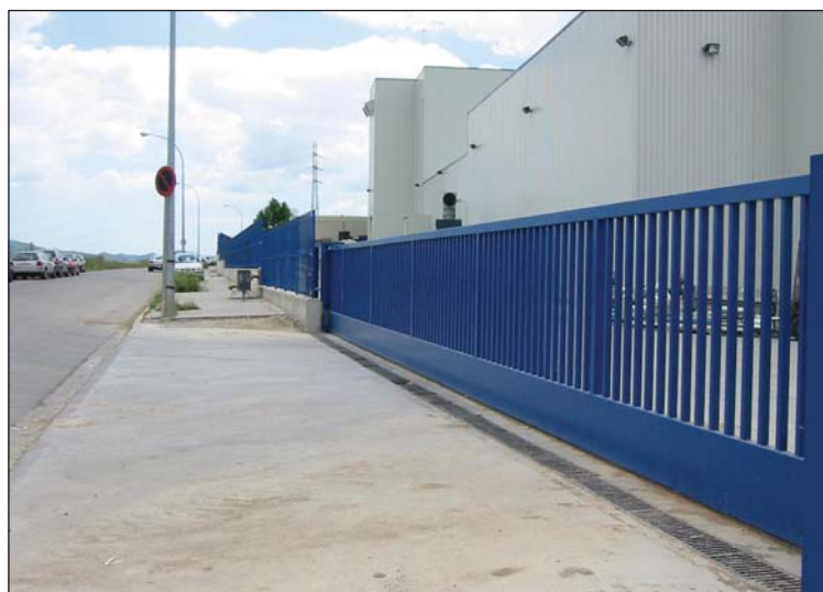
Puerta barrotera con zócalo de chapa.
