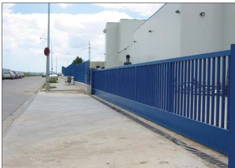
Puerta barrotera con zócalo de chapa.
