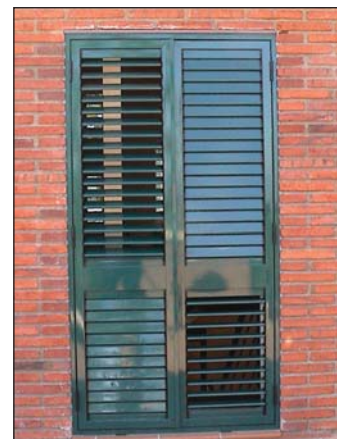
Mallorquina a dos hojas con lamas orientables.
