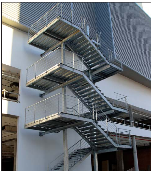
Escalera recta con descansillo y barandilla.
