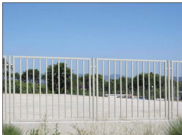
Cerramiento metálico a base de barrotes verticales.
