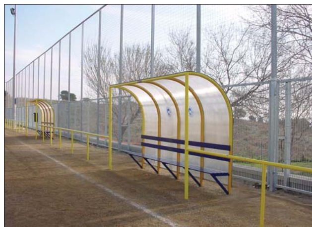
Cerramiento fuerte con postes arriostrados.
