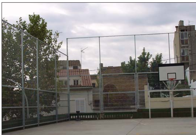
Cerramiento fuerte con refuerzo.
