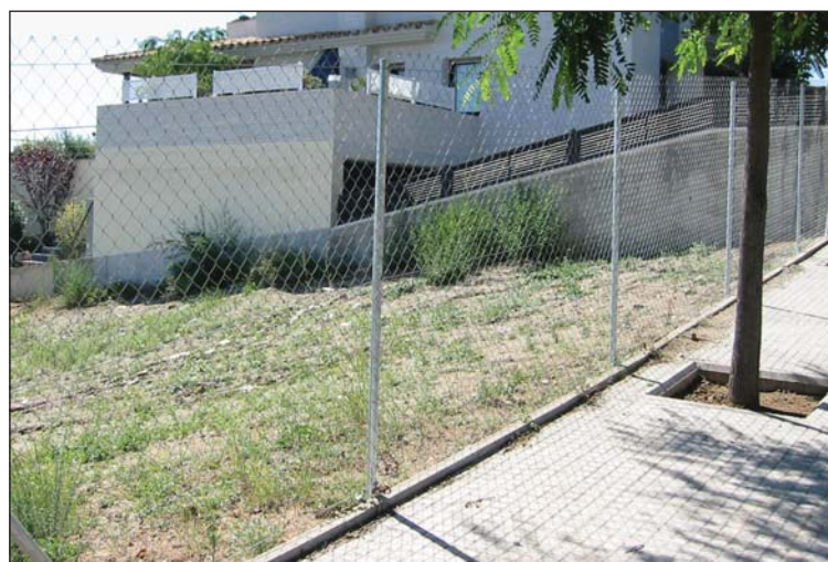
Cercado simple torsión galvanizado.
