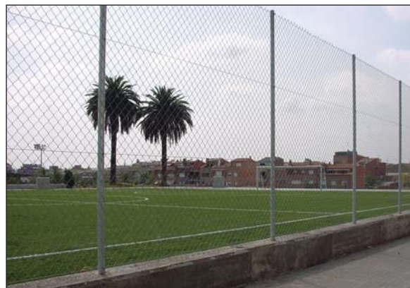
Cercado simple torsión galvanizado.
