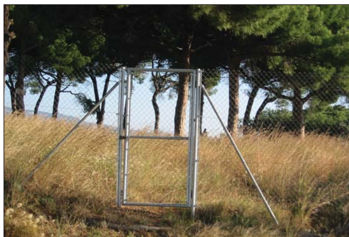
Puerta simple torsión galvanizada una hoja.
